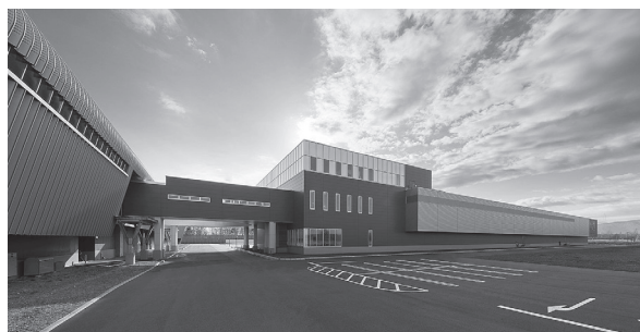
さくらインターネット(株)石狩データセンター
