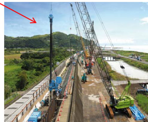
【地震津波対策の堤防改良工事現場】
